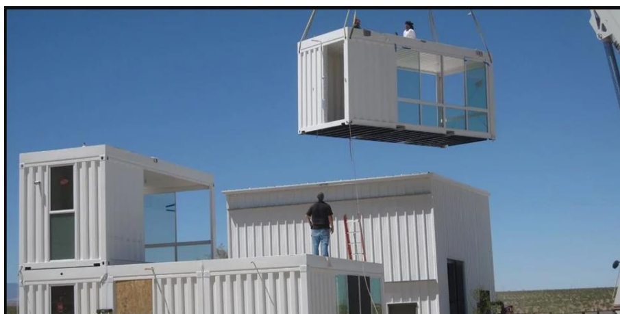
Foto 4–Montagem de container para prédios até três andares fonte: Site bidu.com
