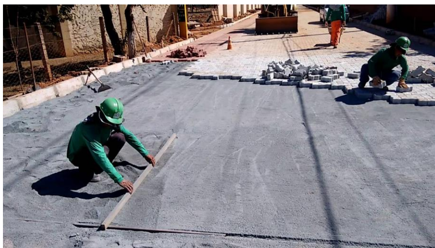
Figura 8: Assentamento blocos de concreto / Fonte: google imagens
