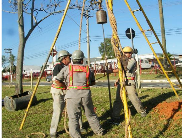
Figura 5: exemplo de perfuração e ensaio de cravação / fonte: Próprio autor.
