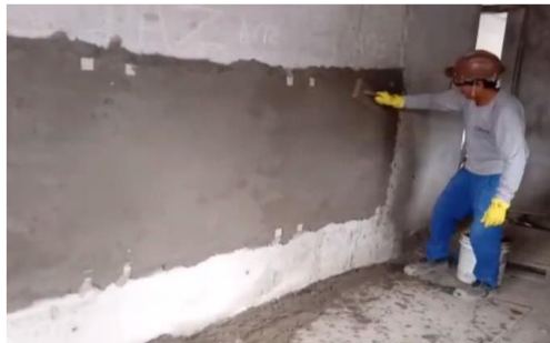
Figura 11: Confeção da camada de argamassa de revestimento
