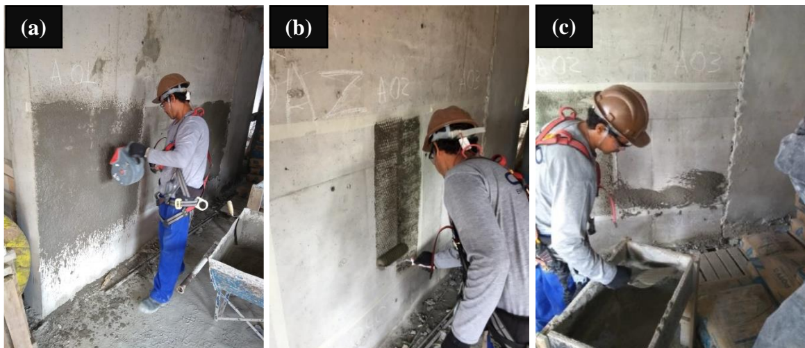
Figura 9: Aplicação de chapisco Fonte: Autores, 2018.
