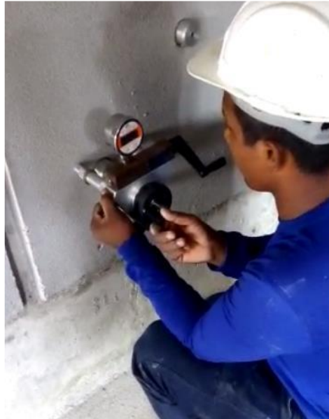
Figura 15: Preparo do dinamômetro para realização do ensaio de arrancamento
