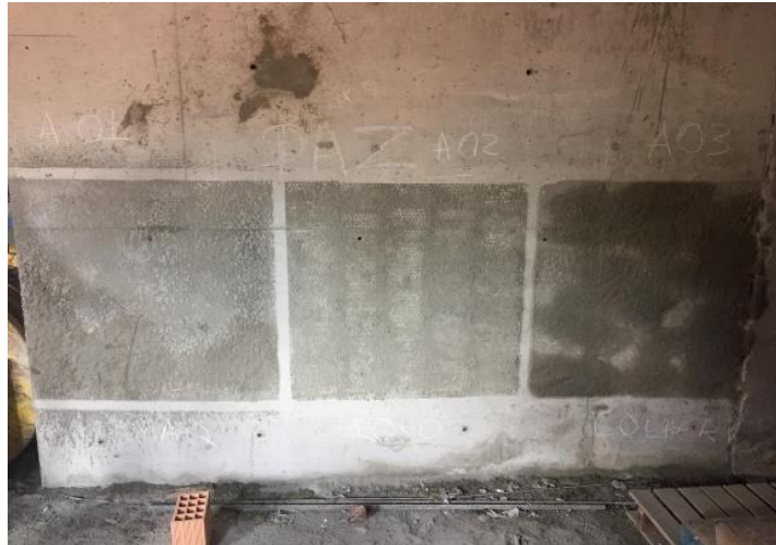
Figura 10: Painéis com chapiscos aplicados Fonte: Autores, 2018.
