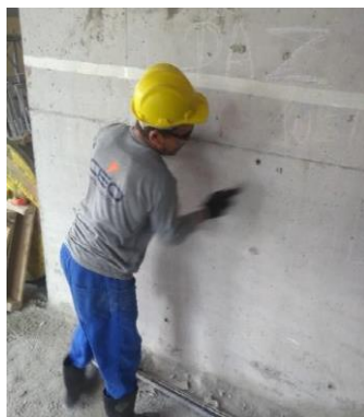
Figura 7: Limpeza da superfície do substrato com escova de cerdas metálicas Fonte: Autores, 2018.
