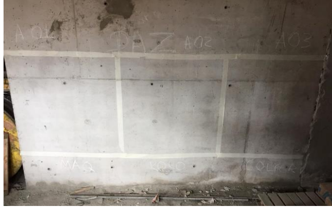
Figura 8: Divisão dos painéis utilizando fita adesiva branca Fonte: Autores, 2018.
