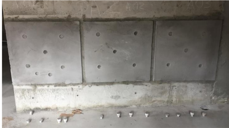
Figura 16: Painéis de Amostragem após os ensaios de arrancamento Fonte: Autores, 2018.
