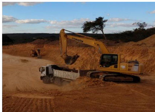
Figura 3: Escavação e carga com escavadeira hidráulica Komatsu PC200
