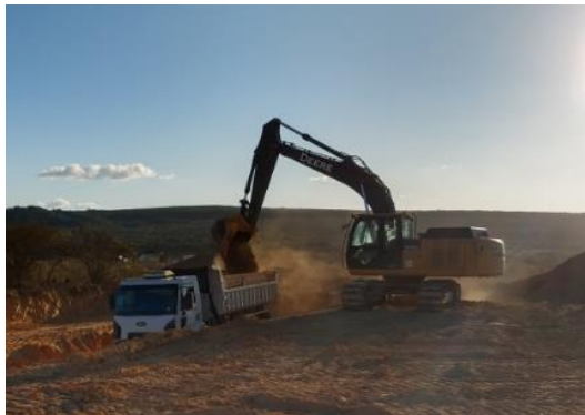
Figura 2: Escavação e carga com escavadeira hidráulica Jeere 210LC
