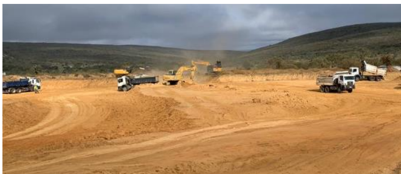
Figura 1: Escavação, carga e transporte de material de jazida
