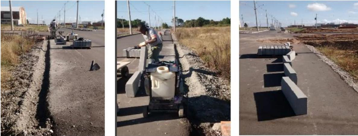
Figura 1: Recorde do asfalto e escavação, para colocação do meio fio. (Fonte do Autor).
