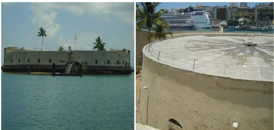
Figura 3: Forte São Marcelo e seu reservatório de Aproveitamento de Água de Chuva. Fonte: Thomaz (2015, p.13).
