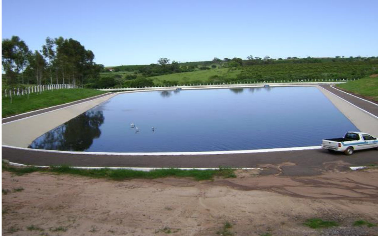
FIGURA 7 – Lagoa Anaeróbia
