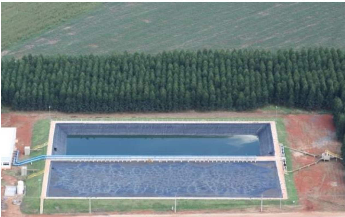
FIGURA 8 – Lagoa aeróbia ou aerada
