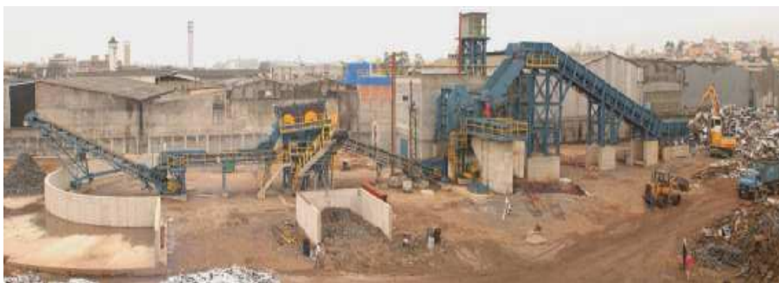
Figura 5 – Instalação de um triturador Shredder
