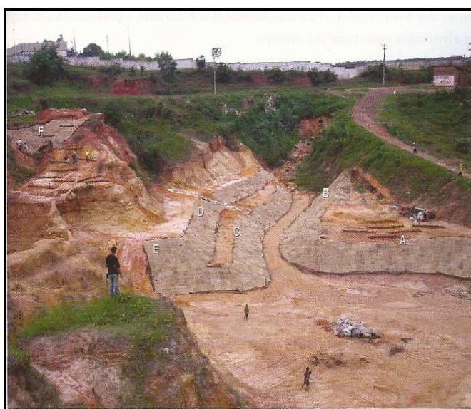
Figura 7: Área com aplicação da técnica de bioengenharia.
