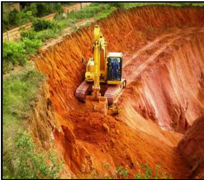
Figura 8: Processo de retaludamento da voçoroca.
