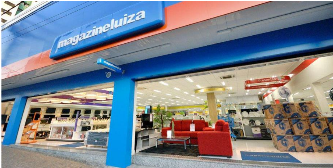
Figura 3- Exemplo de fachada sem vitrine, da rede de lojas Magazine Luiza, Brasil. Fonte: http://gad.com.br/images/galeria/00a0e84e256dc... , acesso em: Mar.2017.
