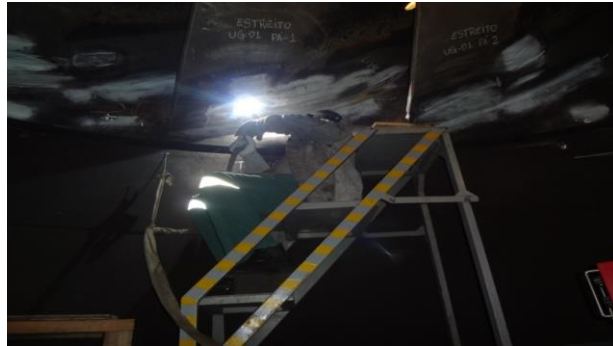
Figura 19: Soldagem da pá 1 com aço carbono.
