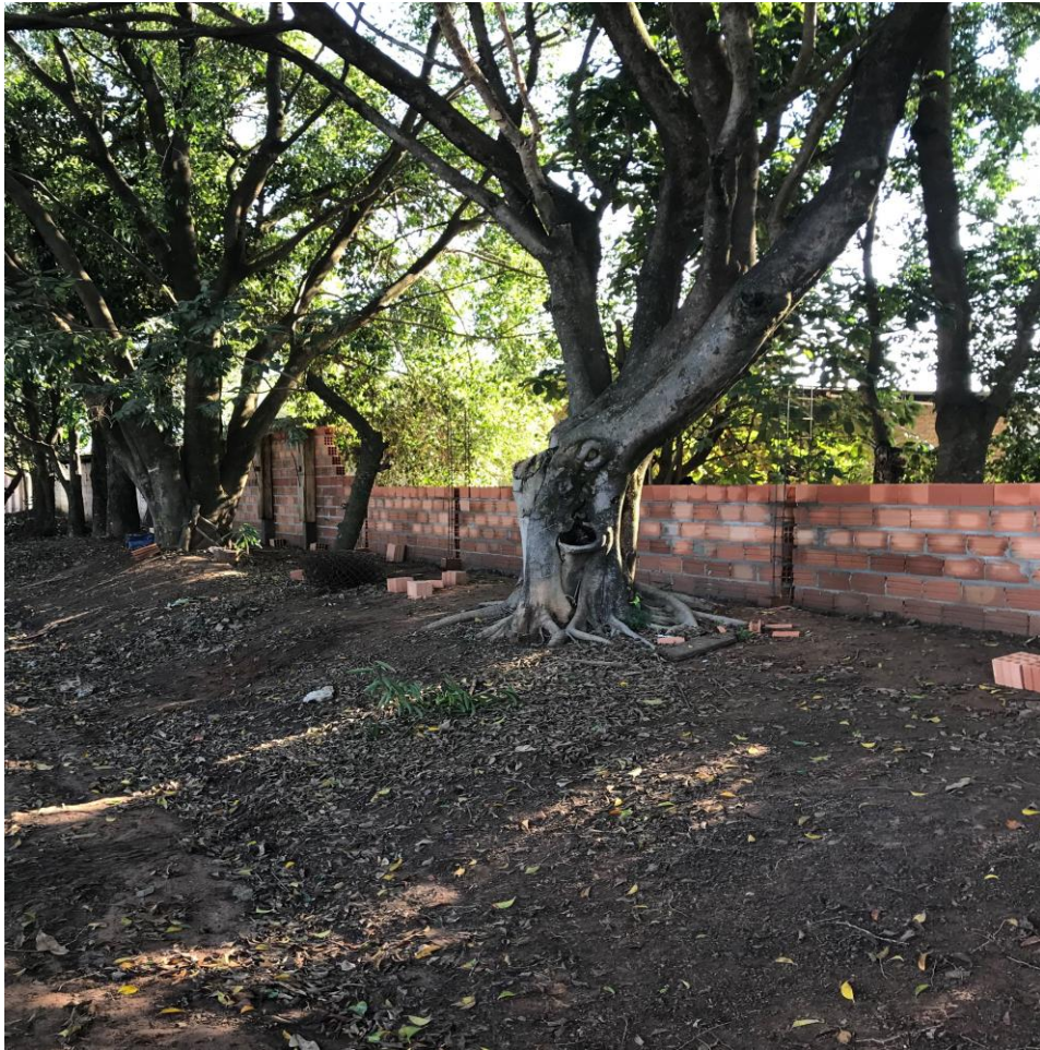
Figura 1. Fase de construção do muro.
