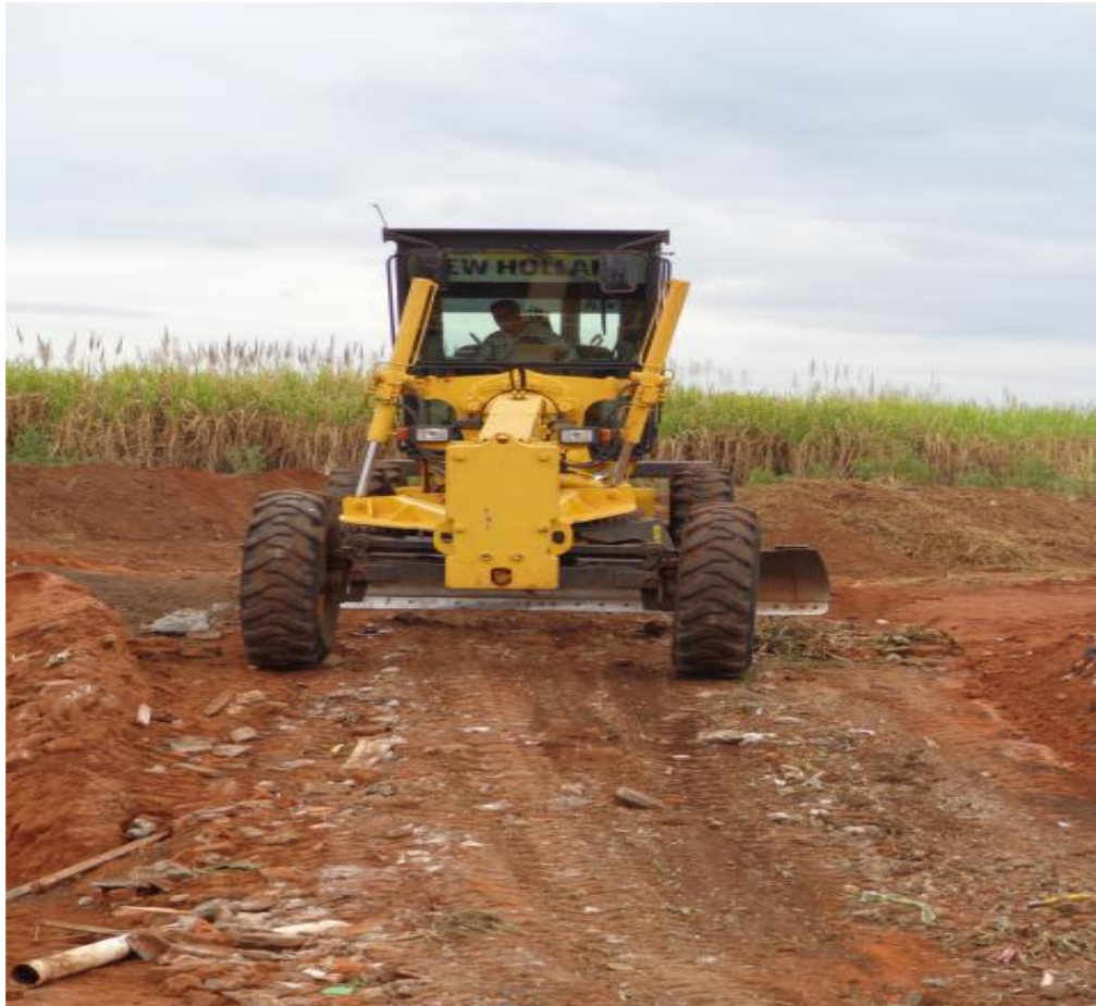
Figura 6. Reutilização dos RCC.
