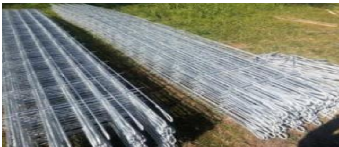
Figura 7- Malhas de aço para inclusão no aterro.
