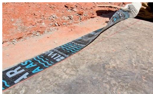
Figura 7: Instalação da manta acústica. Fonte: Google Imagens
