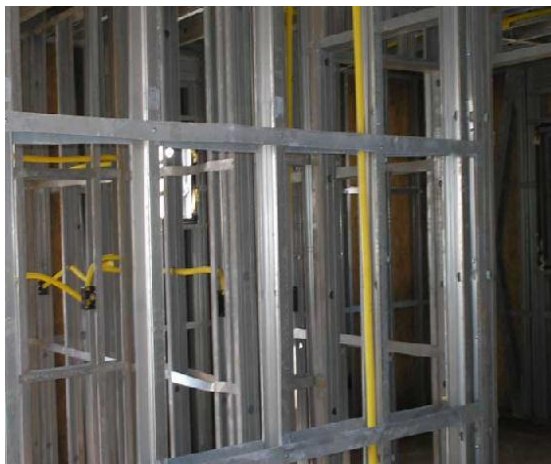
Figura 9: Instalação Elétrica. Fonte: <www.metalica.com.br>
