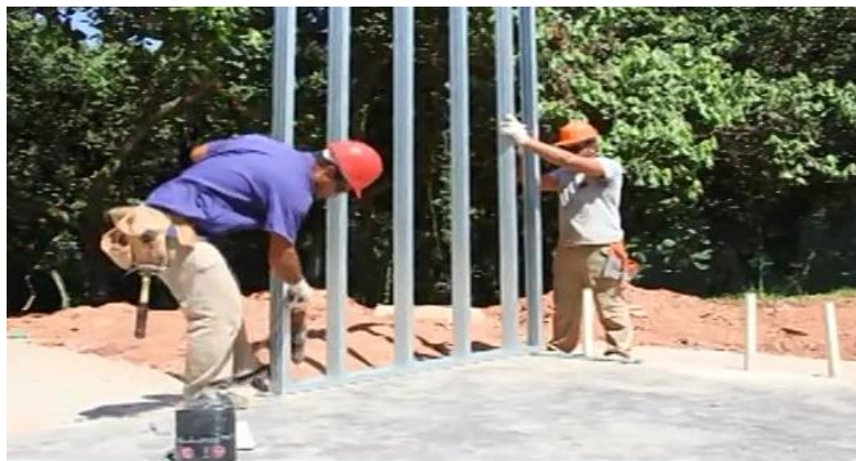
Figura 8: Fixação dos painéis metálicos com furadeira. Fonte: Google Imagens
