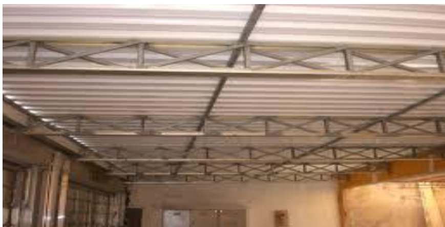
Figura 14: Telhado de Estrutura Metálica. Fonte: Google Imagens.
