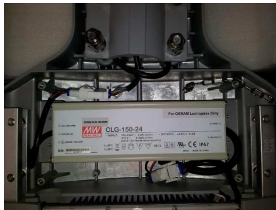
Figura 19 – Driver de acionamento. Fonte: Anglogold Ashanti, 2012.
