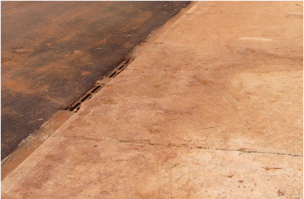
Figura4. Boca de lobo com grelha já terminado
