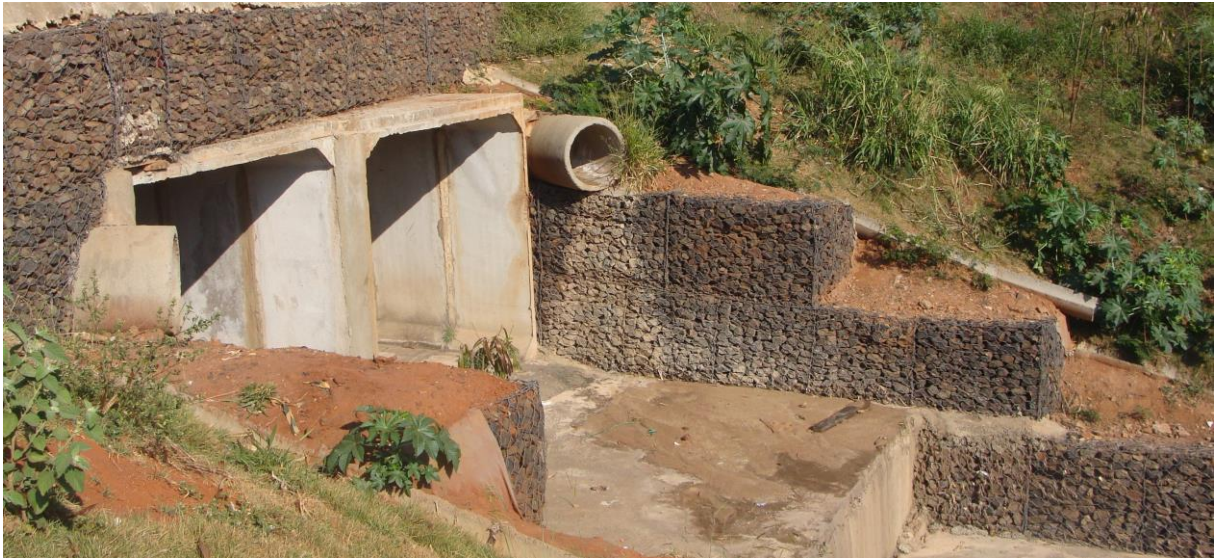
Figura 2. Gabião tipo caixa
