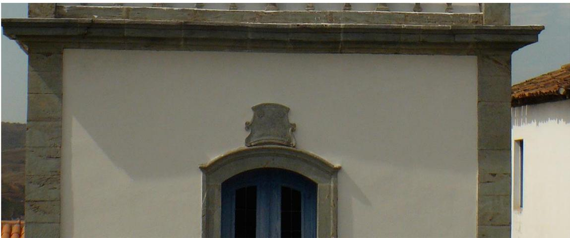
**Figura 3- Fachada pintado com tinta de base mineral.**
