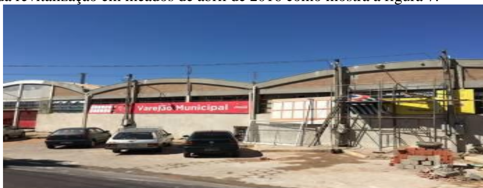
Figura 6 – emboço parcial da fachada do mercado Municipal Fonte: MONTEALTOAGORA-(2018).
