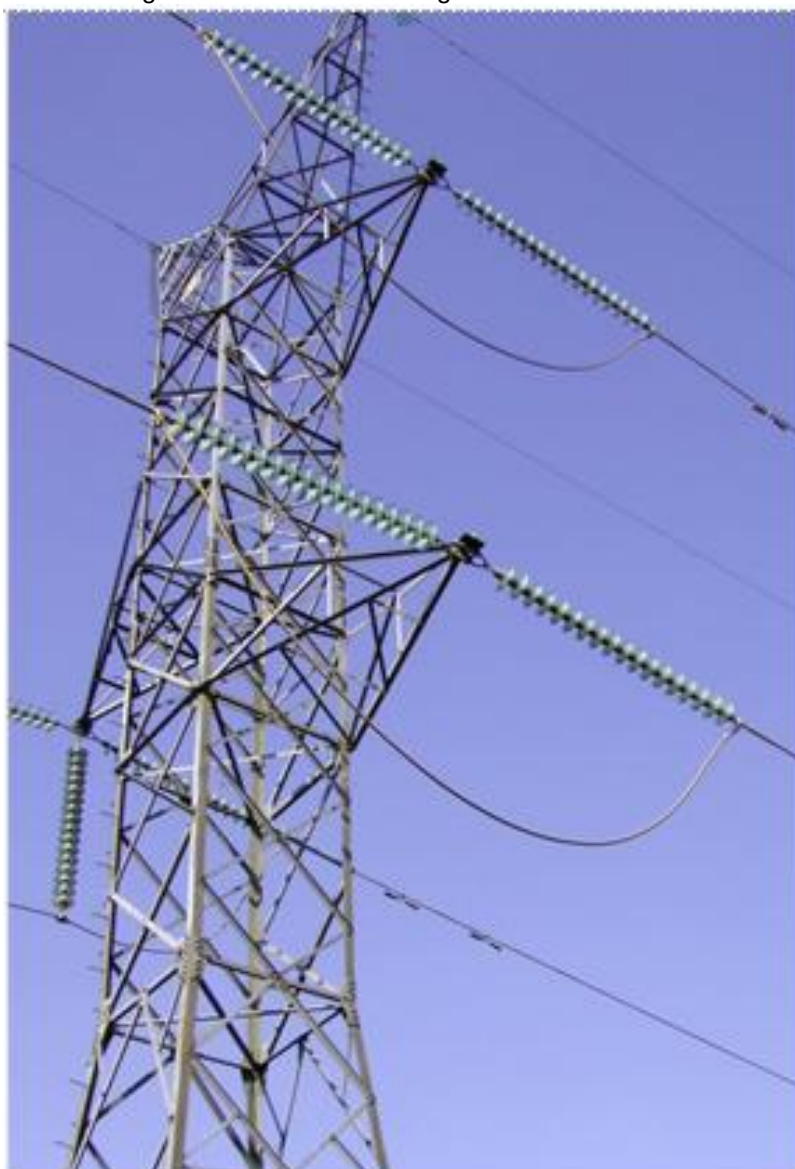
Figura 1 – Torre de ancoragem - isoladores
