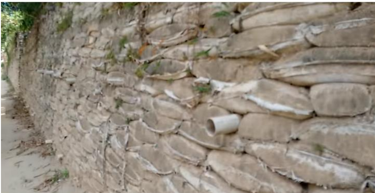
Figura 9: Aplicação de contenção de encosta.
