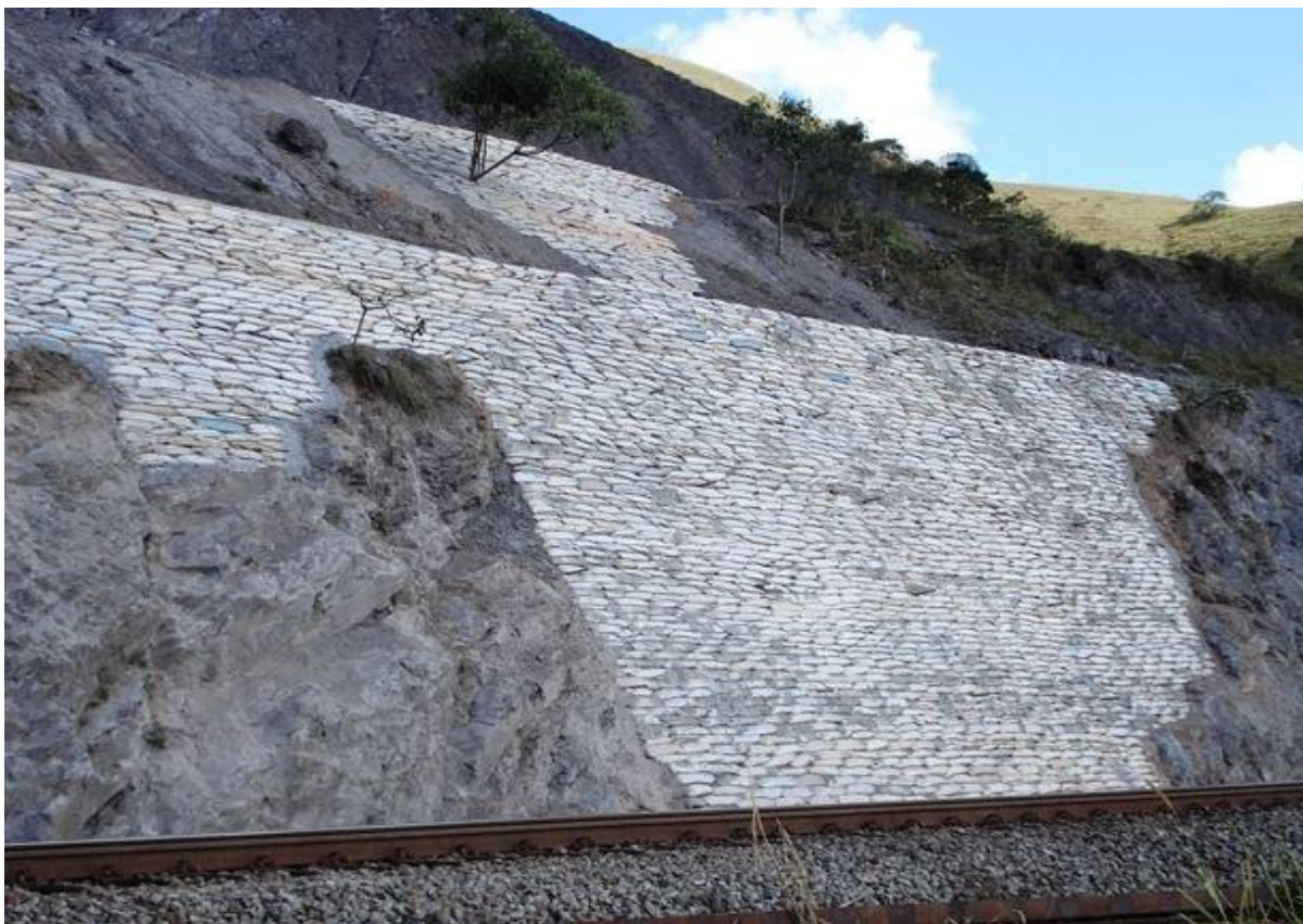
Figura 4: Recuperação de erosão em taludes
