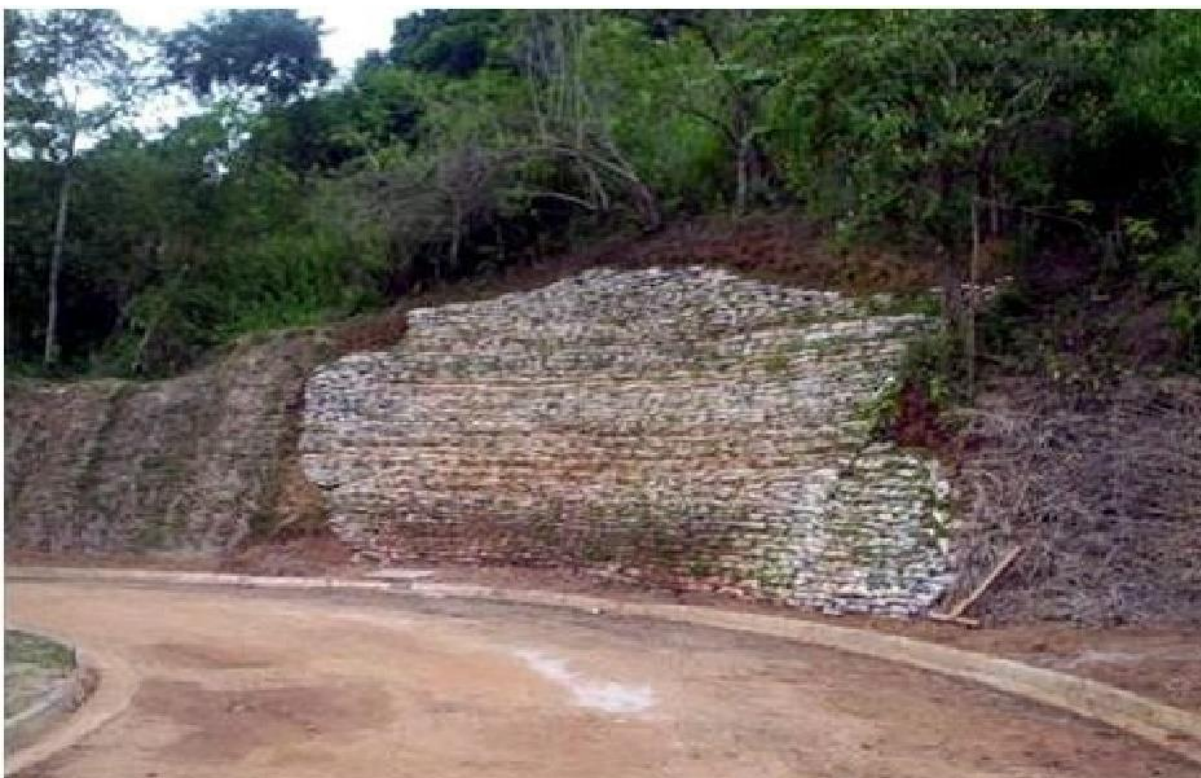
Figura 5: Recuperação de morro em beira de estrada com Rip-rap
