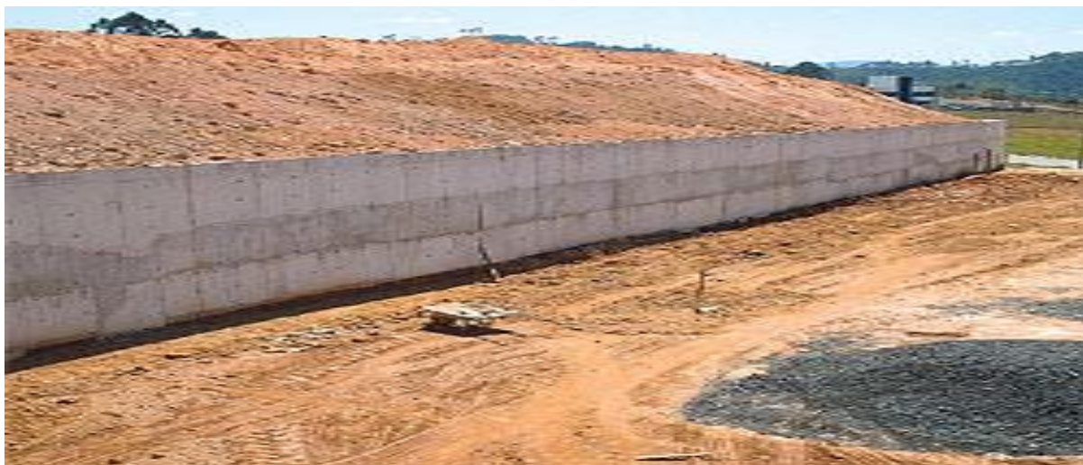
Figura 8: Muro de arrimo de concreto armado
