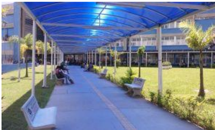
Figura – 2: Visão cobertura de acesso.
