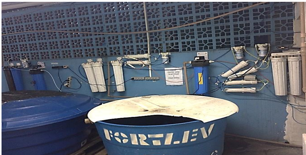
Figura 2. Foto do sistema de filtragem especial de reverse osmose e deionizada. Fonte: Moraes, P.V., (2016).
