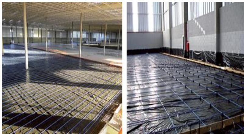
Figura 4- Camada de deslizamento e armação ativa
