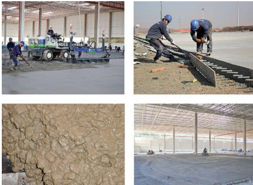
Figura 6- Etapas do pavimento de concreto com fibras.
