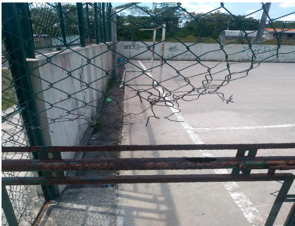
Figura 3: Gradil do portão e alambrado. Fonte: Próprio.
