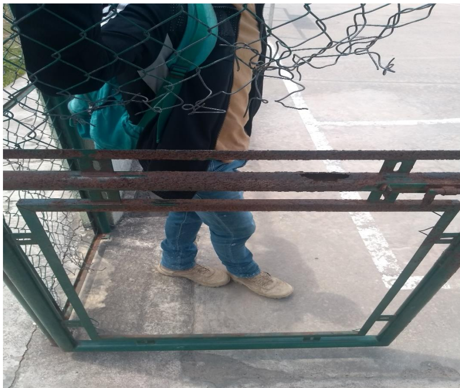
Figura 4: Portão. Fonte: Próprio.
