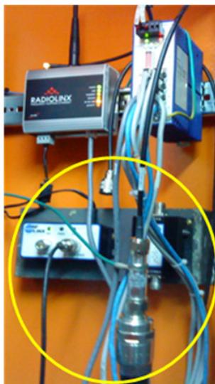
Figura 10: Ligação do cabo coaxial do rádio no conector de proteção contra descarga atmosférica
