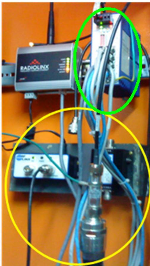
Figura 12: Instalação de Switch não gerenciável no Painel
