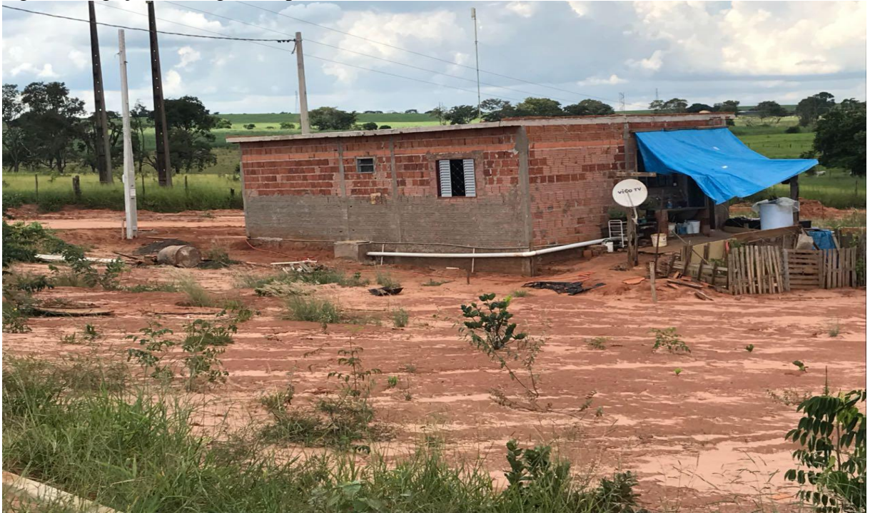
Figura 4: ligações de esgoto improvisadas.
