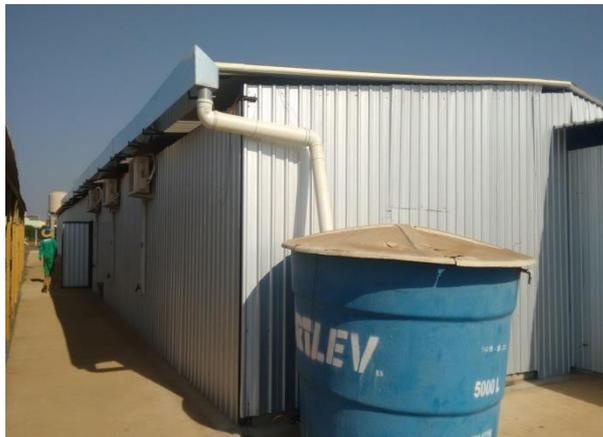
**Figura 05** - Sistema de aproveitamento de água de chuva
