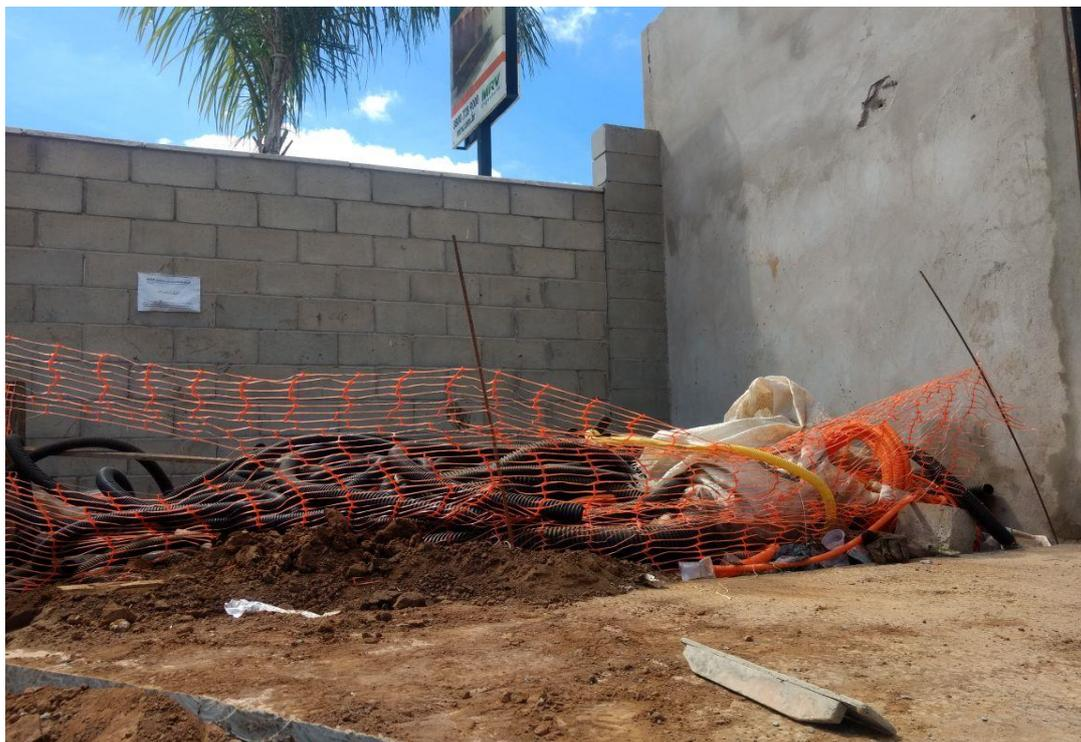
**Figura 02** - Armazenamento incorreto de tubulações elétricas.
