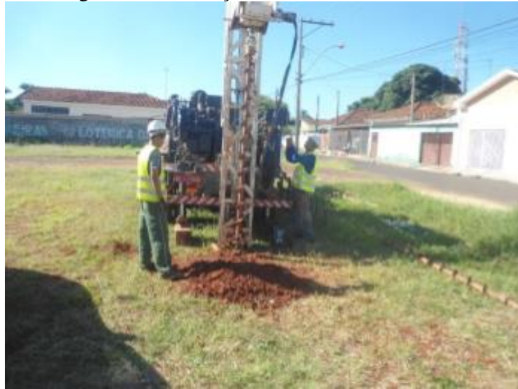
Figura 3 – Perfuração com Trado Mecanizado
