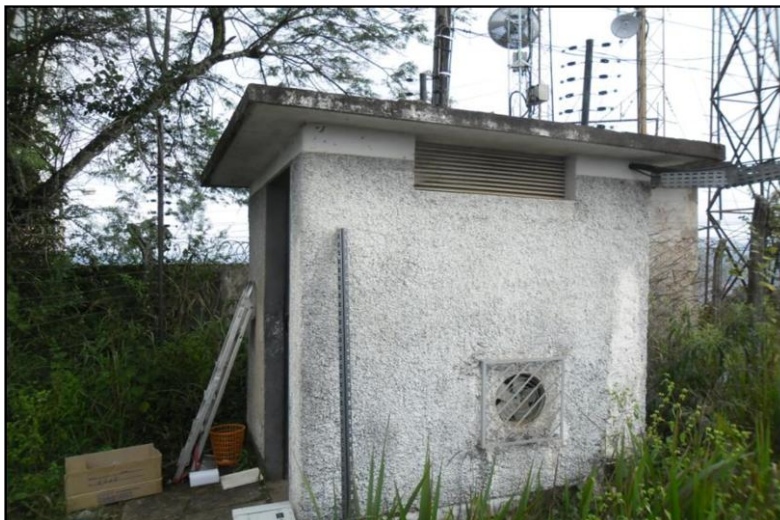
Foto 3 – Abrigo existente na Estação de Barão de Cocais - MG
