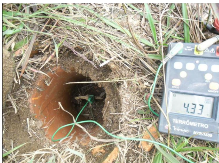
Foto 7 – Aferição da resistividade da 2ª haste existente
