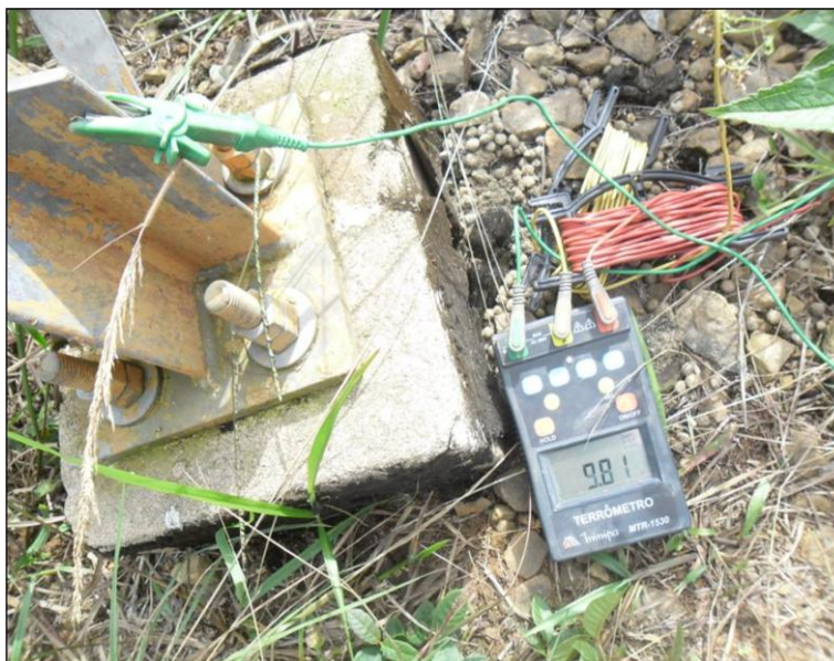
Foto 4 – Aferição da resistividade da torre de 20 metros
