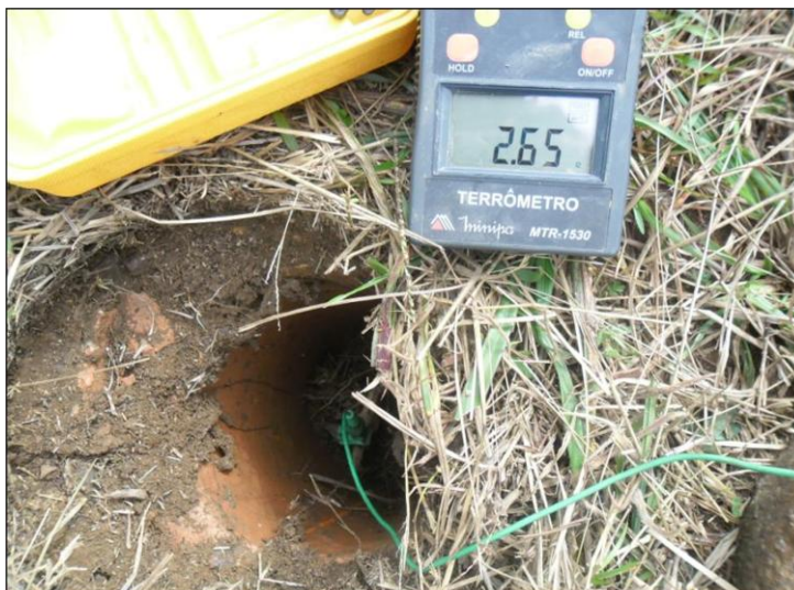
Foto 6 – Aferição da resistividade da 1ª haste existente
