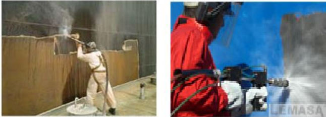
Figura 6. Tratamento da Superfície a Pintar com Jato Abrasivo e Hidrojateamento
