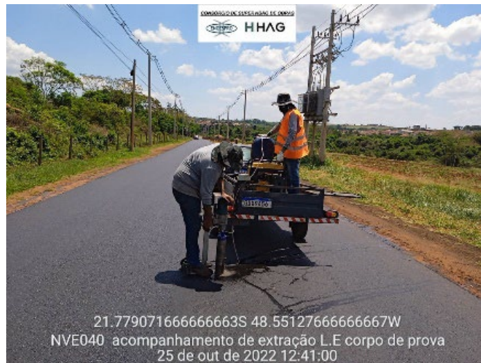
Figura 4 – Processo de recapeamento - Conferência para retirada do corpo de prova
