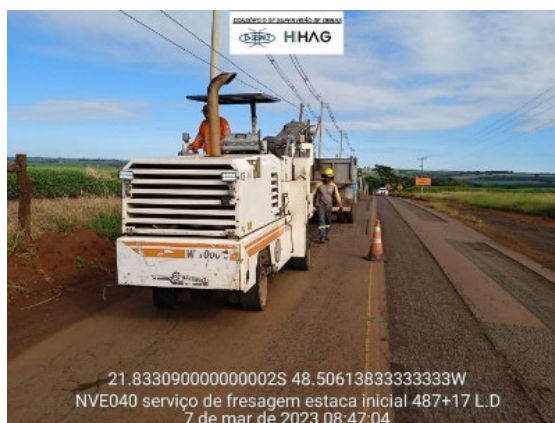
Figura 1 – Processo de recapeamento - fresagem
