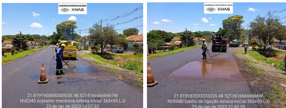
Figura 2 – Processo de recapeamento - Limpeza mecânica
