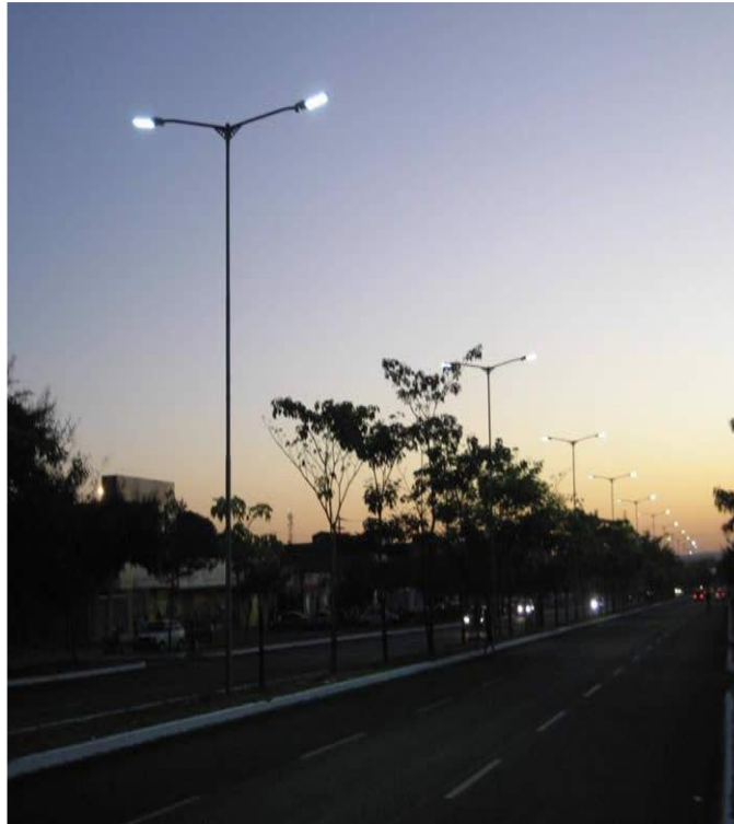
Figura 5- Avenida LO 19 em Palmas - TO iluminada pelas luminárias BBE LU6.
