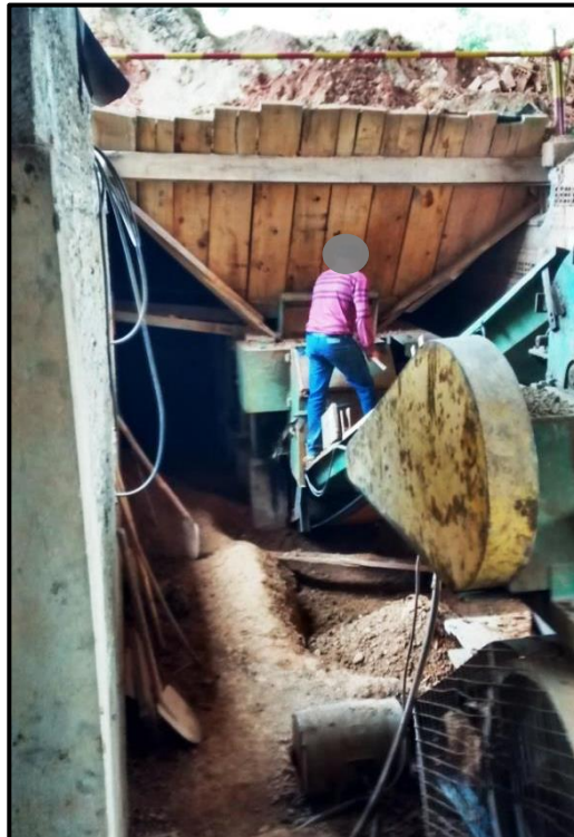
FIGURA 40 – Funcionários realizando o desentupimento do depósito de argila. Fonte: Autor (2016).
