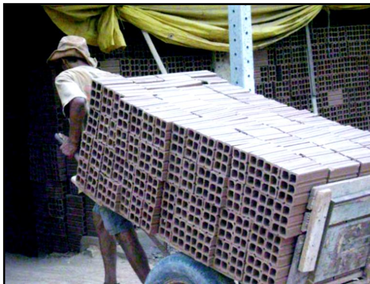
FIGURA 05 – Trabalhador transportando tijolos com o auxílio de carrinhos manuais conhecidos como gambetas ou carriolas.
