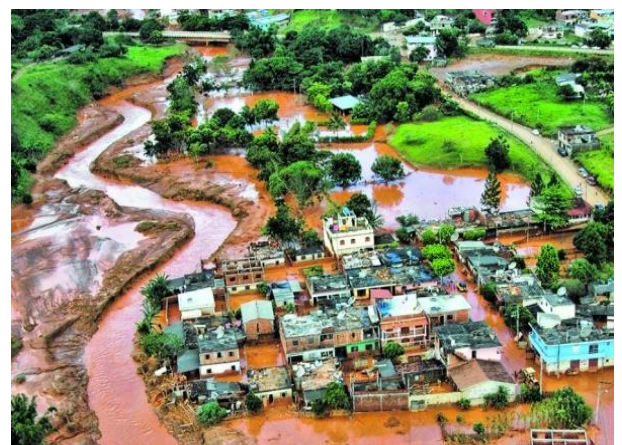
Figura 05: Rompimento Barragem Mineradora Rio Pomba-Cataguases Fonte: DNPM
