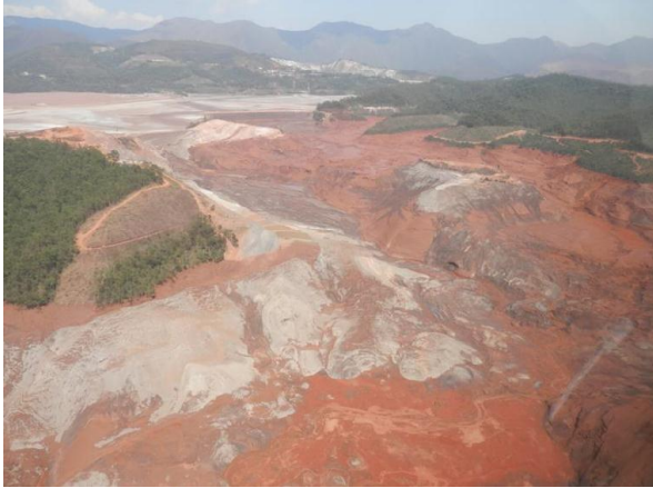
Figura 08: Barragem de Fundão após o rompimento Feam
