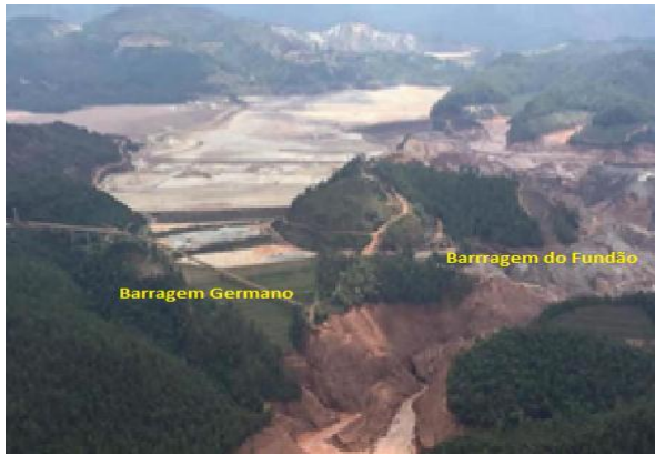
Figura 02: Barragem - Mineradora Samarco Fonte: DNPM
