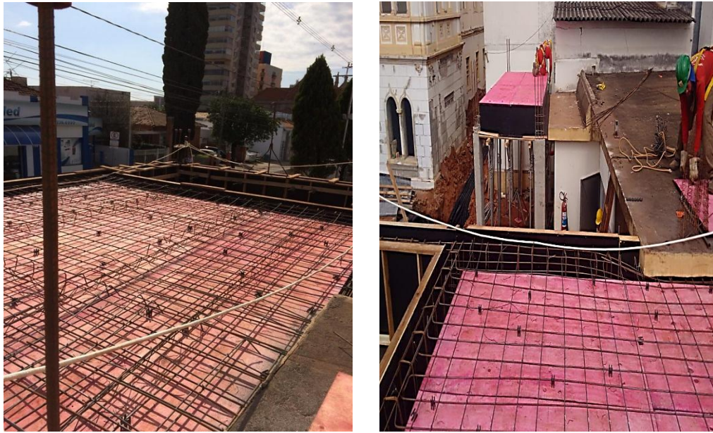
Figura 17 e 18: Execução de laje (formas e armadura)
