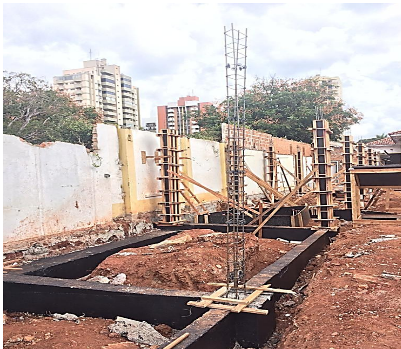
Figura 7: Viga baldrame impermeabilizada
