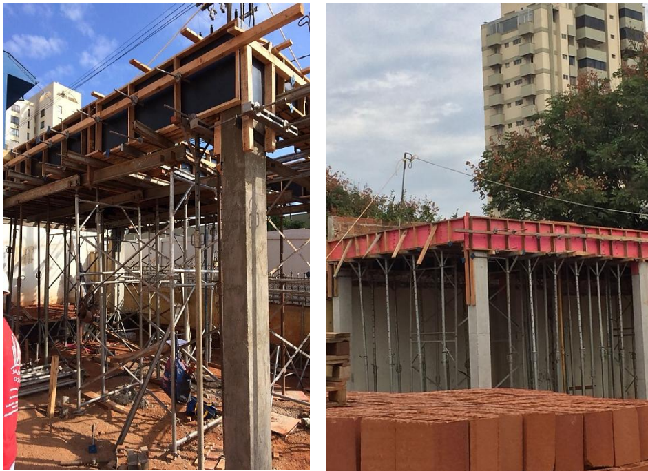
Figura 15 e 16: Execução de vigas moldadas in loco
