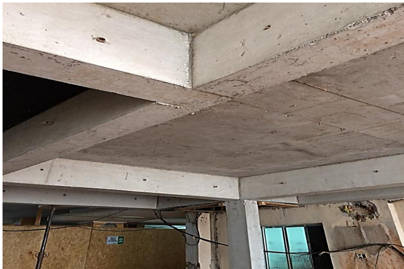
Figura 19: Laje desenformada
