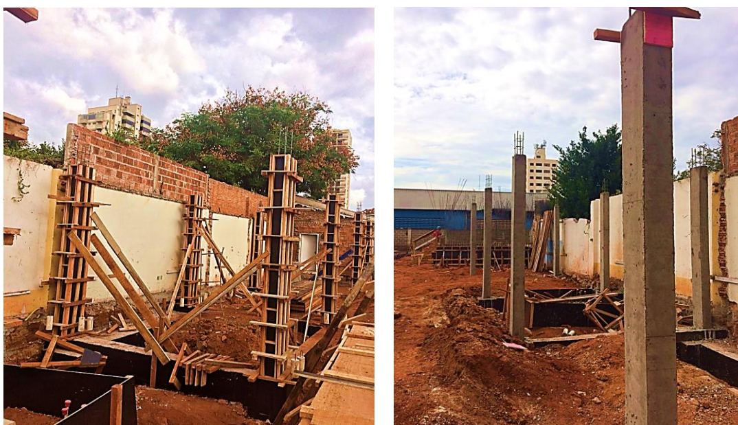
Figuras 8 e 9: Pilares Moldados in loco
