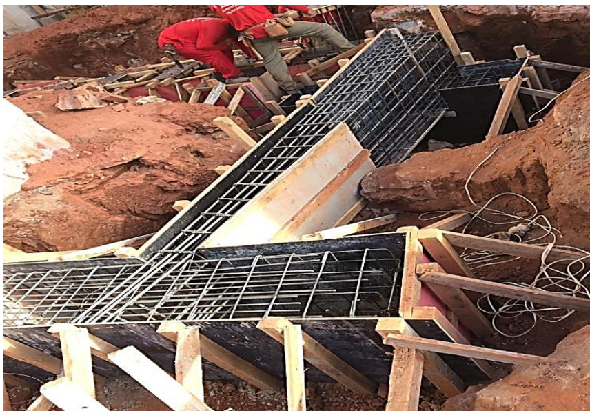
Figura 6: Armadura sobreposta nas formas (viga baldrame e bloco de fundação)
