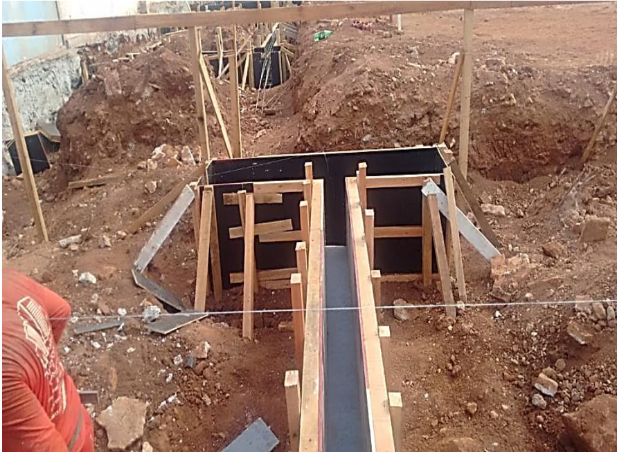
Figura 5: Formas para viga baldrame e bloco de fundação.
