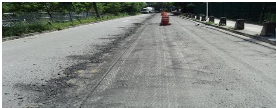
Figura 2 – Fresagem de Capa de Rolamento. Fonte: http://celsowistuba.blogspot.com
