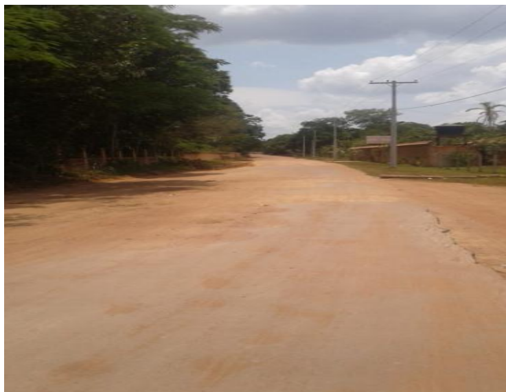
Figura 7 – Trecho da Estrada do Caldeirão. Fonte: Próprio autor (2018).
