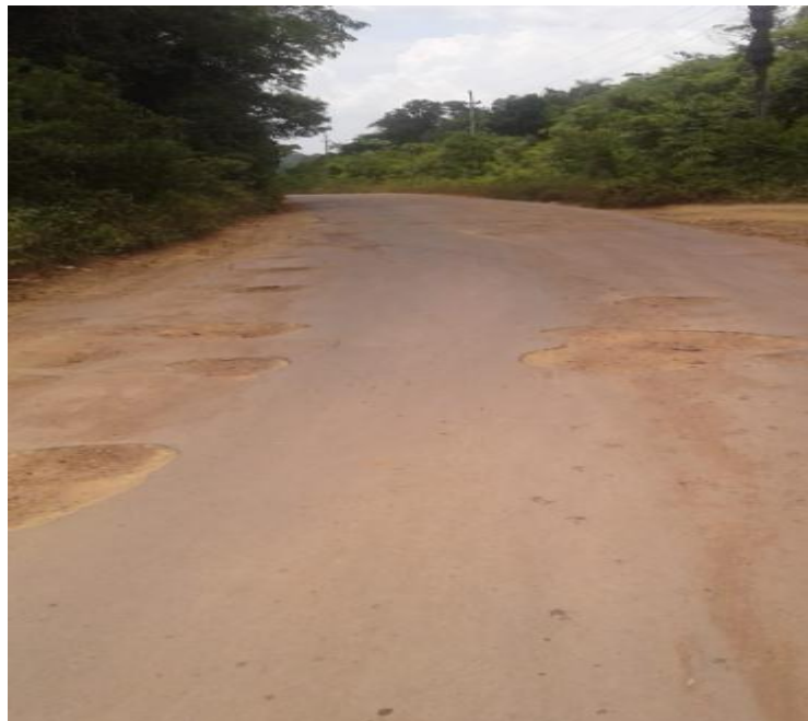
Figura 6 – Trecho da Estrada do Caldeirão. Fonte: Próprio autor (2018).
