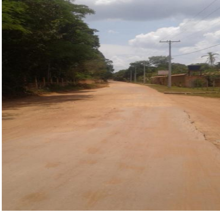
Figura 5 – Trecho da Estrada do Caldeirão. Fonte: Próprio autor (2018).
