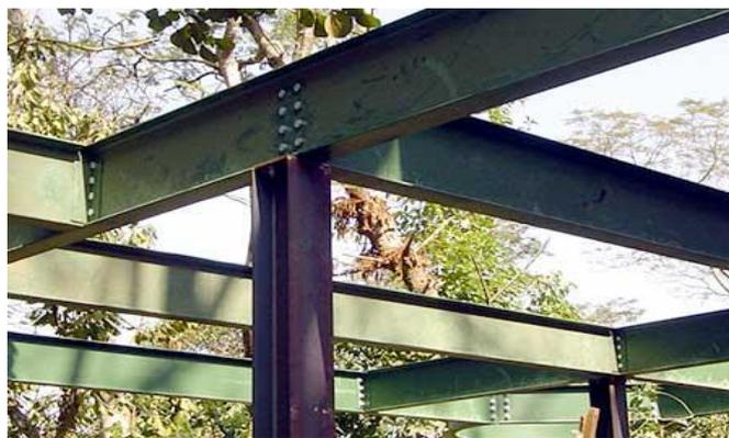
Figura 8: Perfil Laminado. Fonte: <<http://www.pellizzer.com.br>>
