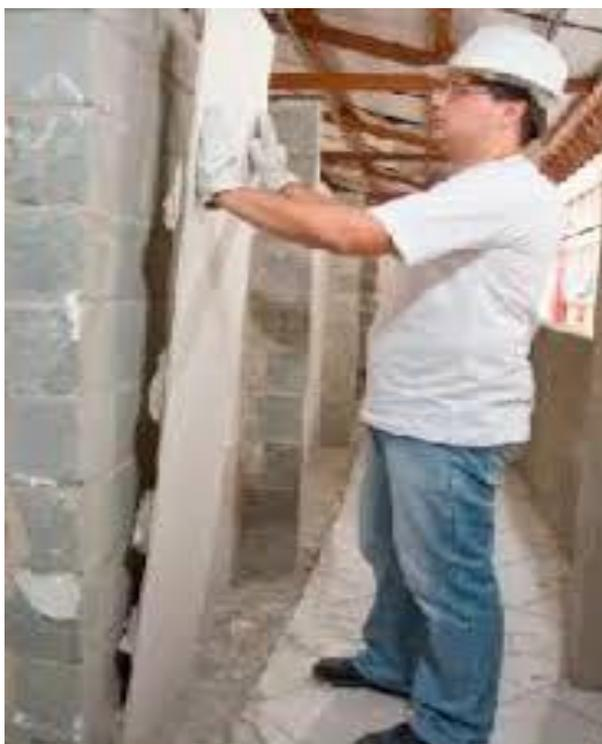
Figura 7: Fixação do revestimento colado Drywall. Fonte: Google imagens.
