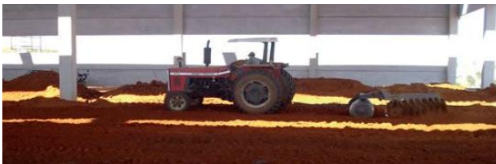
Figura 23 – Preparação de Subleito com grade de disco
