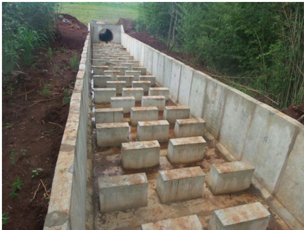
Imagem 6 – Estrutura dissipadora de energia -
