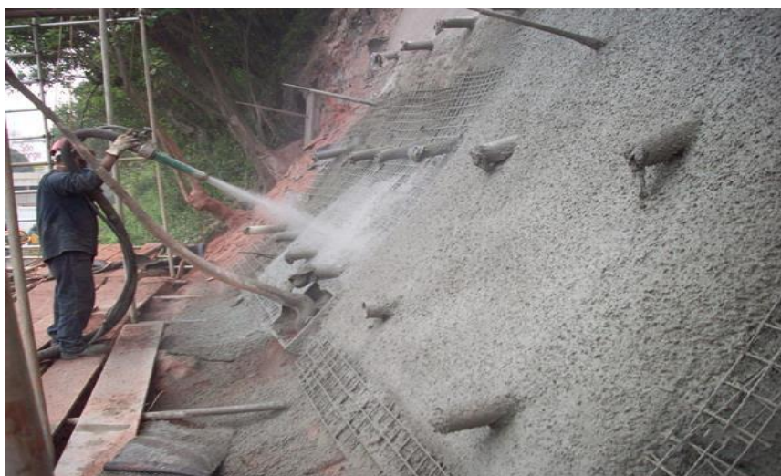
Figura 6: Talude sendo concretado. Fonte : http://www.cprv.com.br/servicos.html acesso em 04 de outubro de 2018 as 17:20
