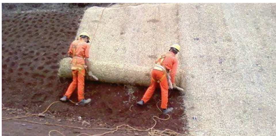
Figura 7: Aplicação da geomanta em um talude. http://infraestruturaurbana17.pini.com.br/solucoes-tecnicas/14/artigo256243-1.aspx acessado em 05 de outubro de 2018 as 16:55h
