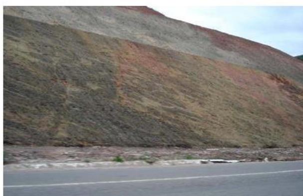
Figura 4: Exemplo de talude natural (em corte) em que se pode observar a sua estrutura particular, associada à vida geológica do maciço, intimamente ligado, entre outras coisas, a ação do intemperismo
