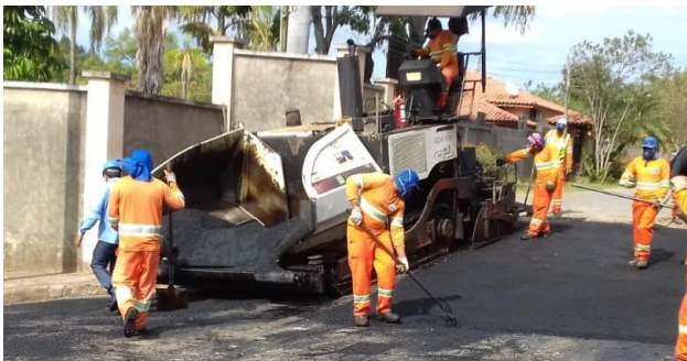
Fonte: Elaborada pelo autor, 2018 Figura 9. Aplicação do revestimento
