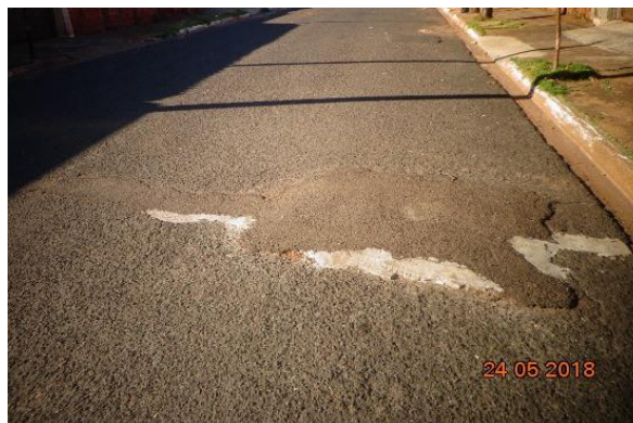
Figura 7. Patologia, remendo
