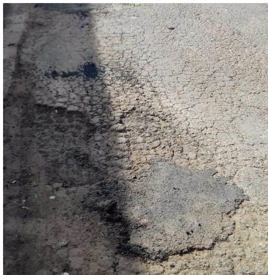
Figura 5. Patologia, trinca tipo couro de jacaré
