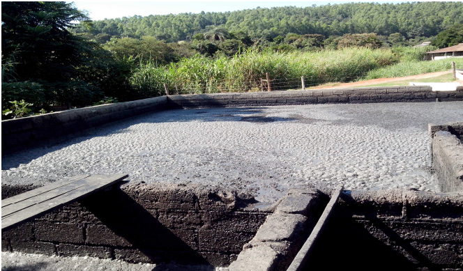
Figura 8- Lagoa de Decantação- 05/2016
