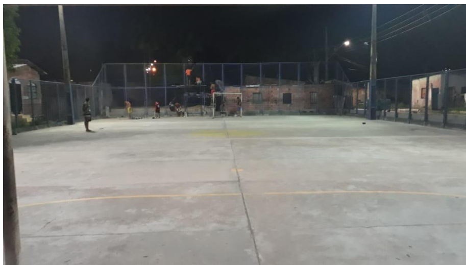
Figura 12: Situação atual do piso II.
