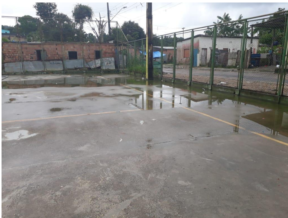
Figura 11: Situação atual do piso I.
