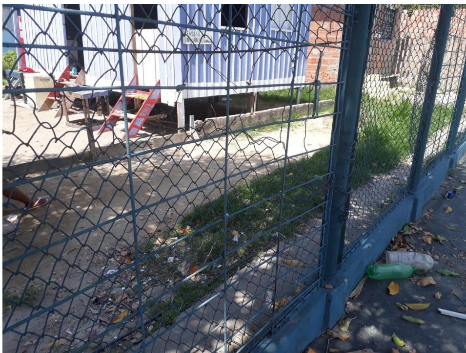
Figura 8: Situação atual das grades II.
