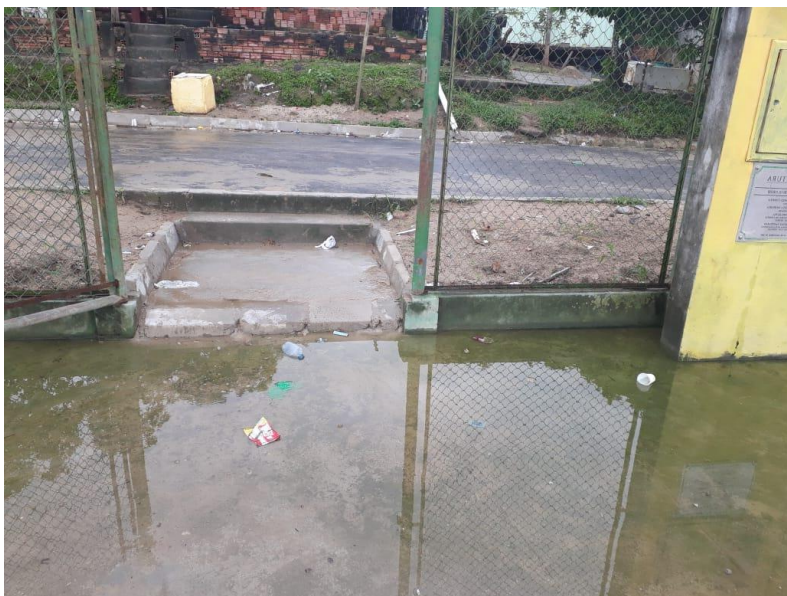
Figura 6: Situação atual dos portões de acesso.
