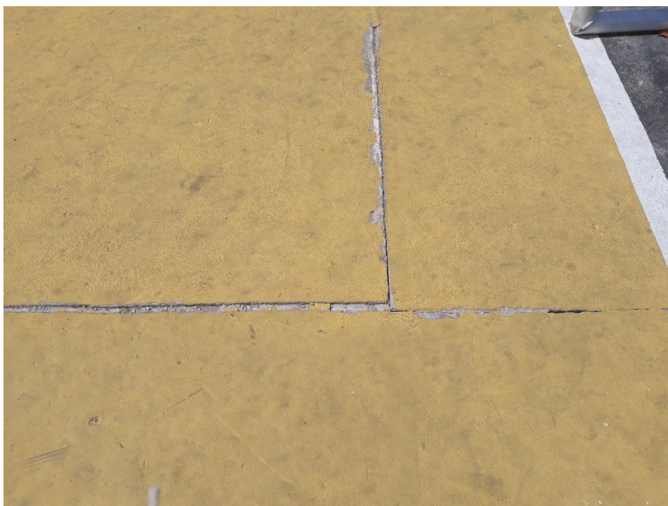
Figura 14: Situação atual do piso IV.
