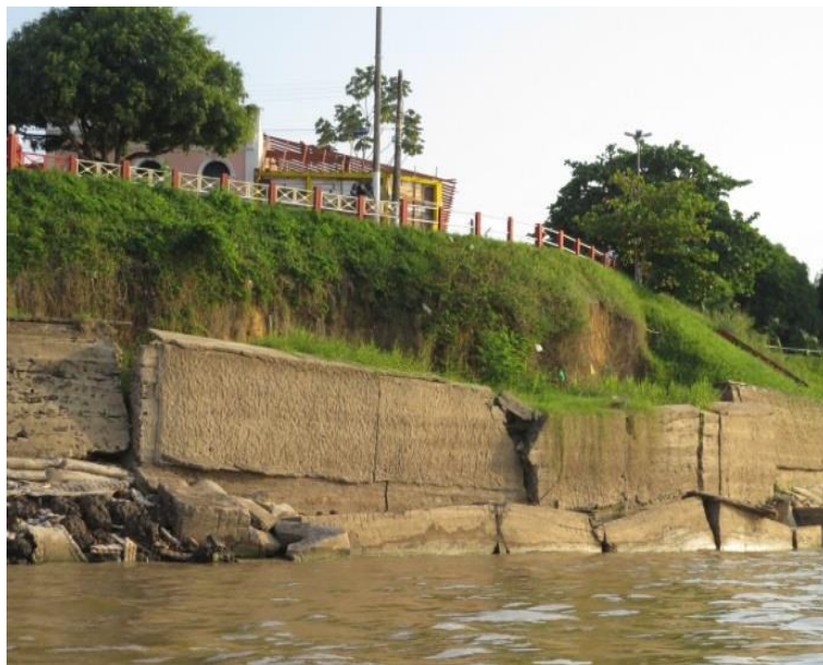
Figura 4: Muro de arrimo na região do Comunas Bar Rua Caetano Preste Fonte: Marques J. A.L
