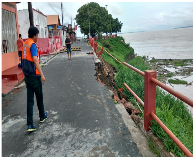
Figura 5: Escorregamento de maciço ocorrido em 2016. Fonte: Daniel Sicsú
